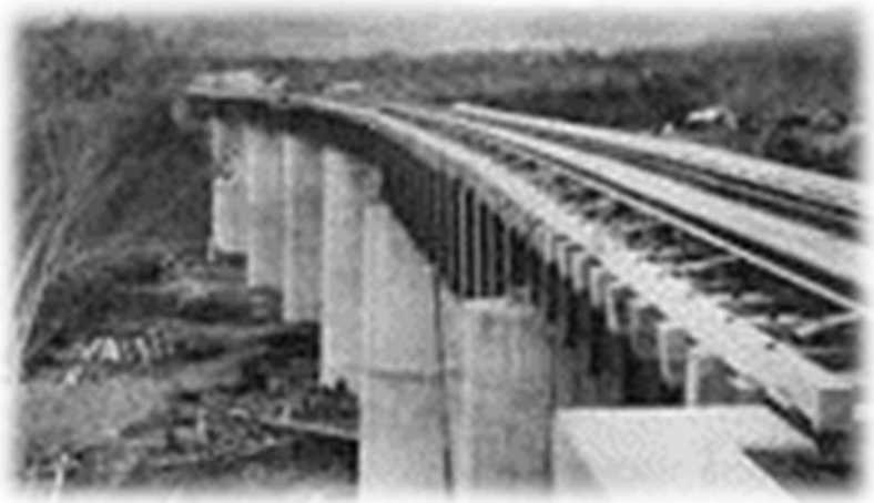
相生線第2網走川橋梁(北見工業大学付属図書館所蔵)
