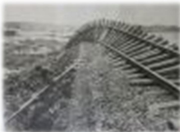
泥流によりねじ曲がった線路 (上富良野町教育委員会提供)
