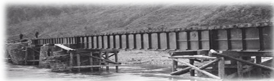
明治40年 余市川橋梁工事 (北海道大学付属図書館所蔵)
